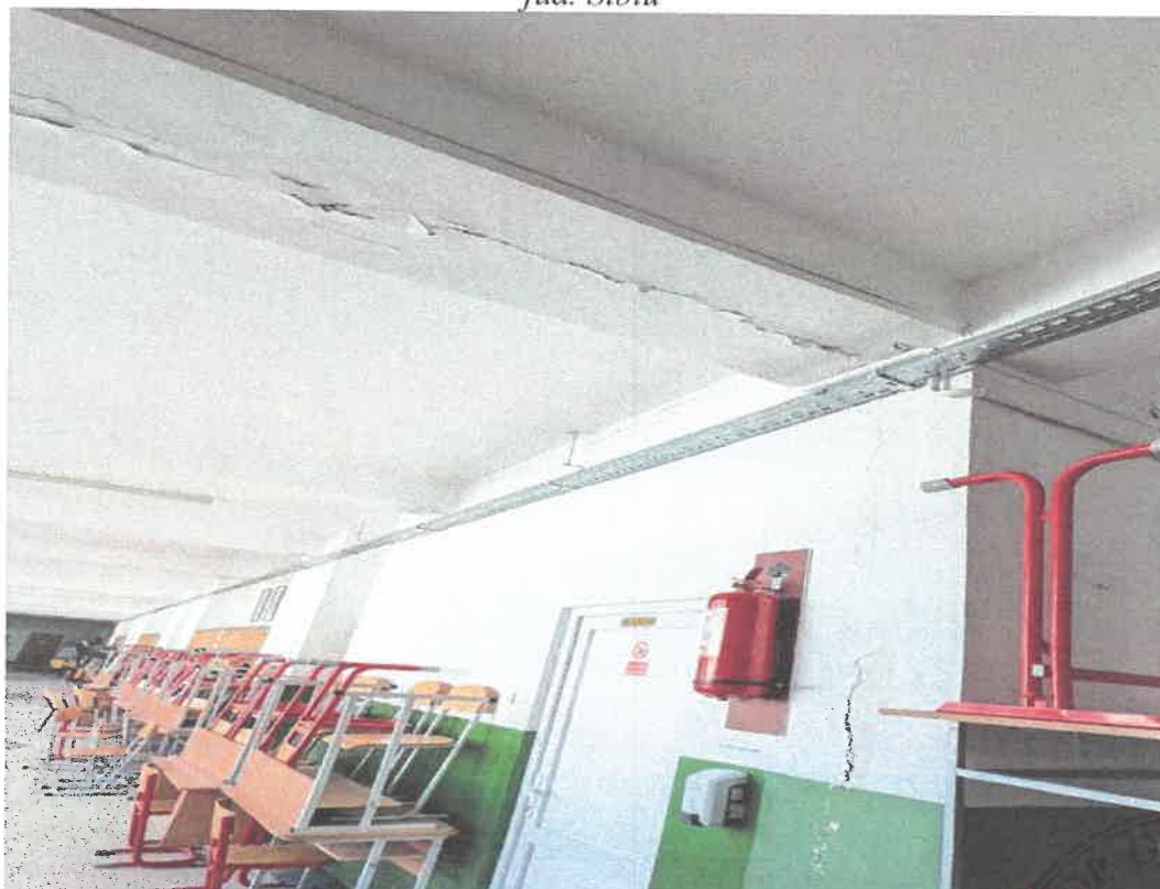
Poza 9. Rost între tronsonul A și C tratat necorespunzător.
