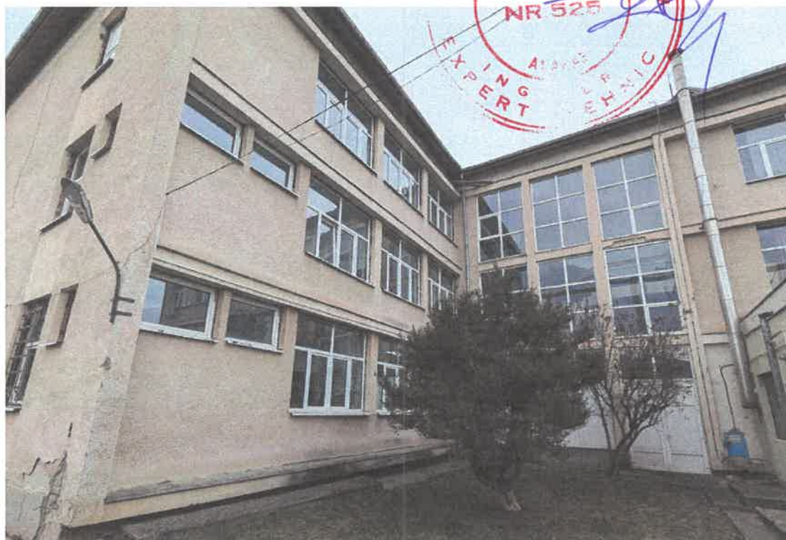
Poza 3. Poza dinspre centrala termica. Se observa unele degradari ale tencuielilor.
