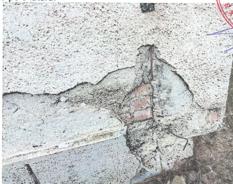
Poza 6. Poza a fatadei se observa portiuni pe care tencuiala a cazut si lipsa trotuarului de garda pe o latura.
