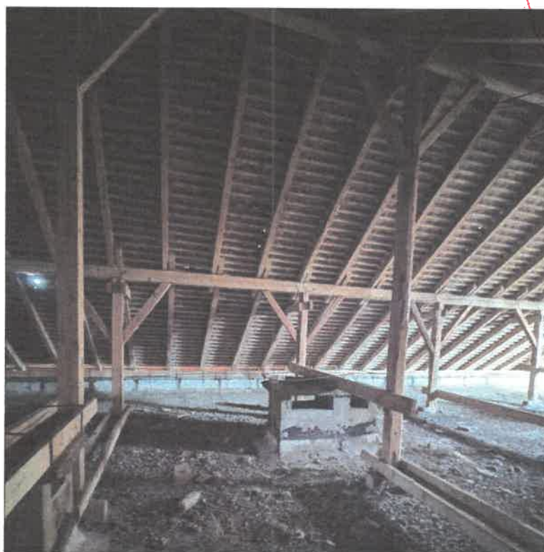
Poza 8. Poza din pod se observa popii contravantuiti panee si capriorii dispusi la pas de 70 cm.
