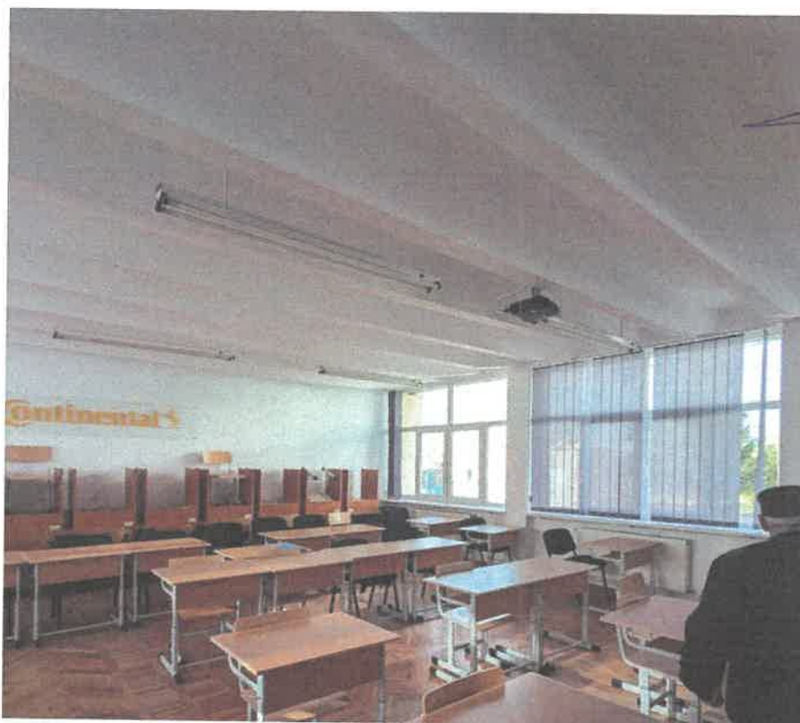
Poza 5. Poza in sala de curs in corpul C se observa planseul cu nervuri dese
