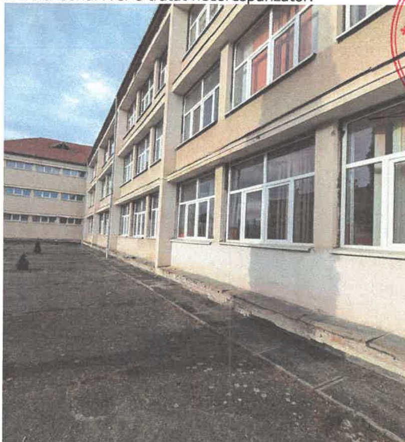
Poza 10. Fatada dinspre strada energeticienilor Se observa parasolarul cu tencuiala cazuta.
