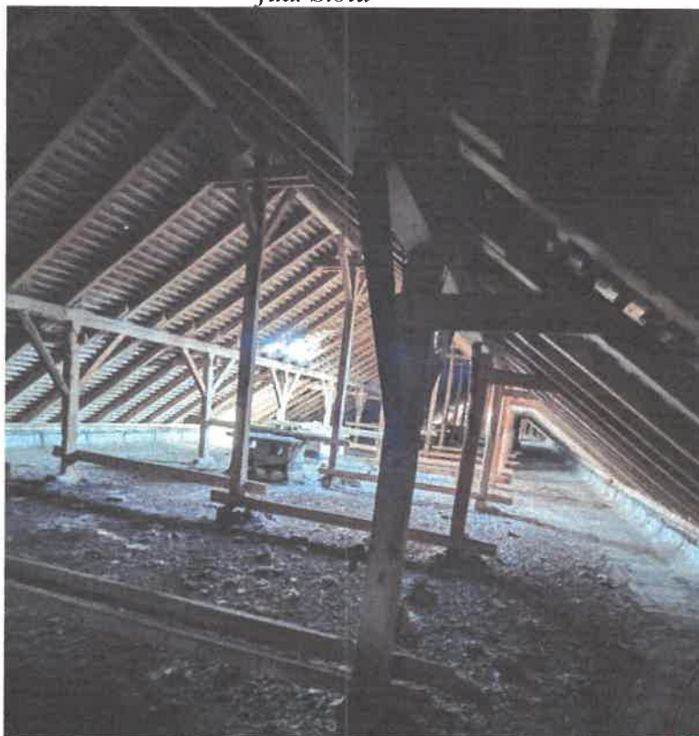
Poza 8. Poza din pod se observa popii contravantuiti panee si capriorii dispusi la pas de 70 cm.
