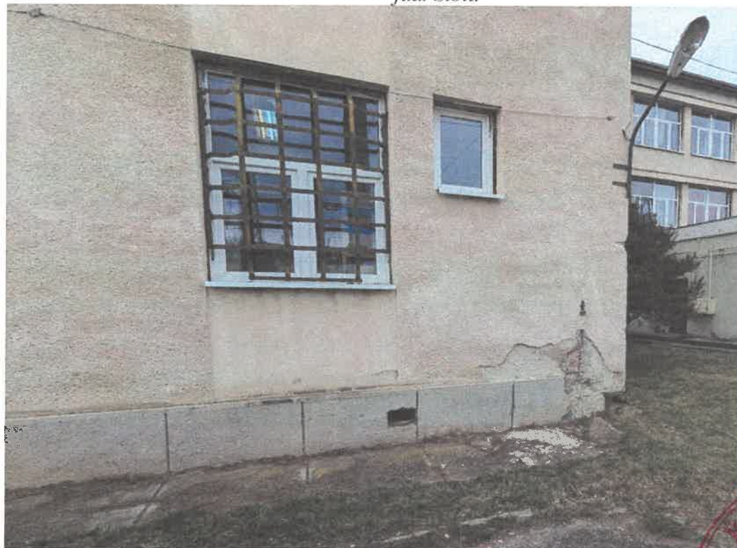
Poza 6. Poza a fatadei se observa portiuni pe care tencuiala a cazut si lipsa trotuarului de garda pe o latura.
